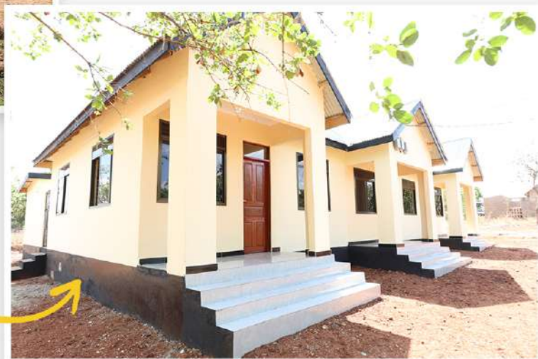
Mwonekano wa jengo la mradi wa makazi ya Watumishi wa Umma lililopo katika Zahanati ya Makunda, Kijiji cha Makunda, Halmashauri ya Wilaya ya Iramba, mkoani Singida.
